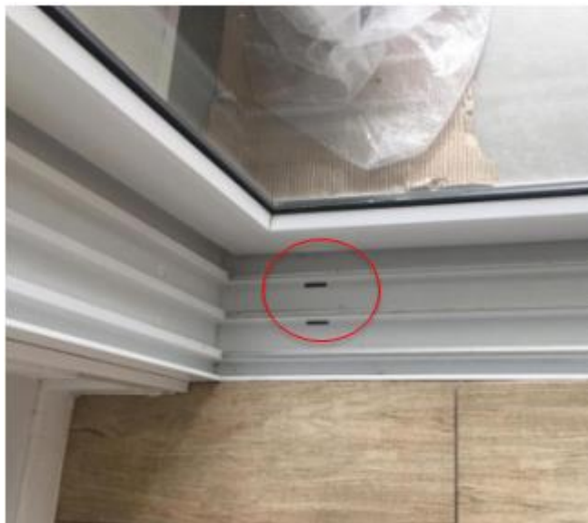
Figura 13 - Usinagem feita para drenagem de água
